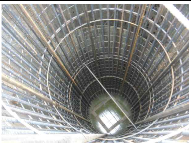
P2 현장타설말뚝 철근망 시공현황
