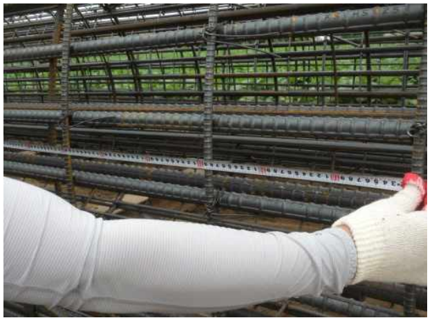
P5 현장타설말뚝 철근망 철근간격측정
