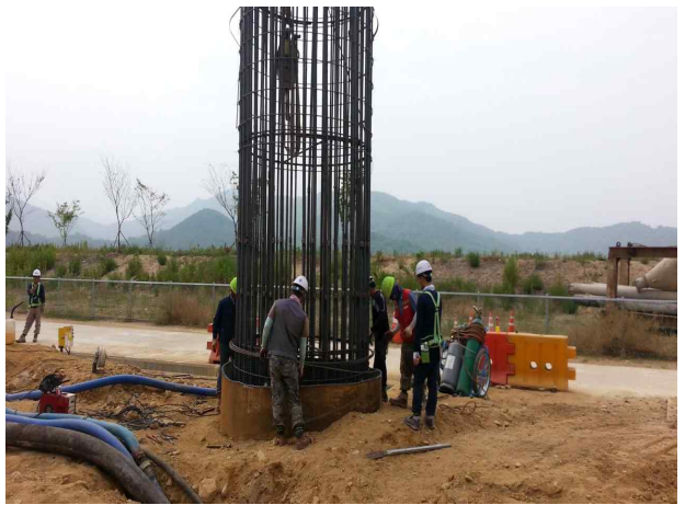
P11 현장타설말뚝 철근망 시공현황
