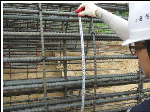
P2 현장타설말뚝 철근망 철근간격측정
