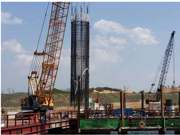
P7 현장타설말뚝 철근망 시공현황
